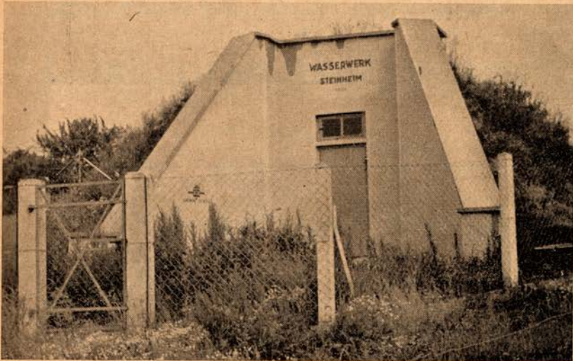
Der Hochbehälter auf dem Kaltenrain
